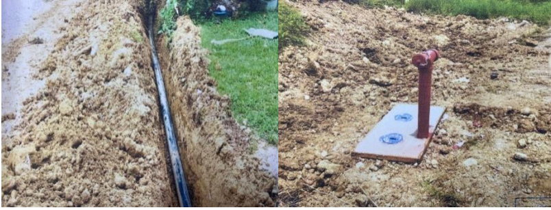
19.โครงการขยายเขตประปาภูมิภาคซอยศาลประติษฐ์ ม.2
