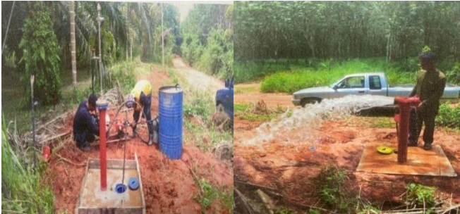
20.โครงการขยายเขตประปาภูมิภาคสายเนินทอง ม.3
