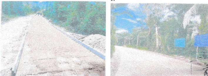
๑๒.โครงการก่อสร้างถนนคสล.สายราษฎร์พัฒนา ส่วนที่เหลือ ม.๑๒
