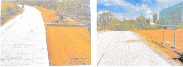
๑๔.โครงการก่อสร้างถนนคสล.สายดอนรักษ์ ซอย๔ (ทำรัง) ม.๑๐ (บ้านดอนรักษ์) (ส่วนที่เหลือ)
