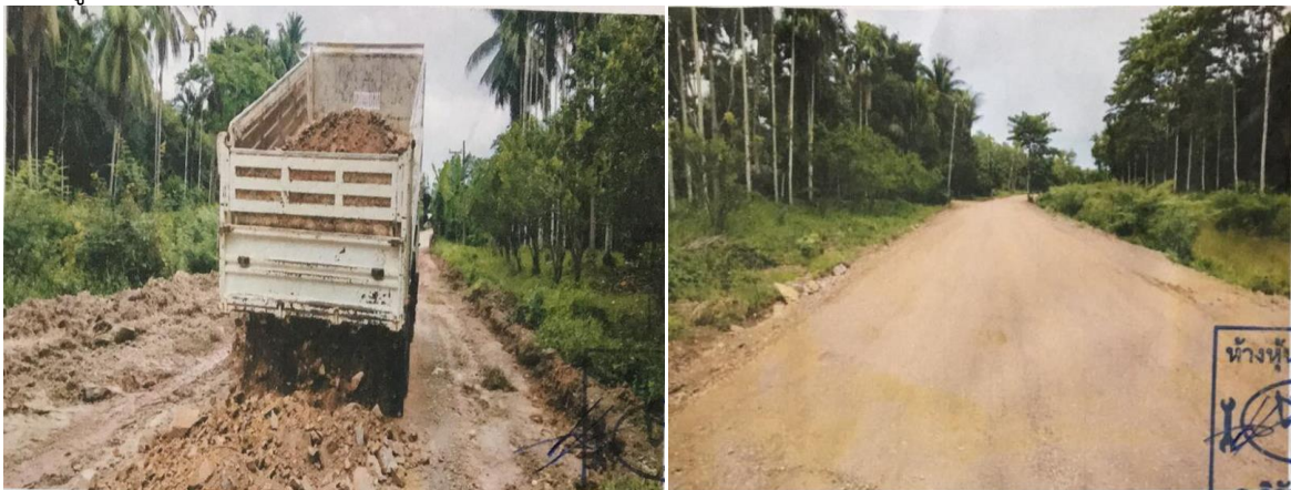
๕. โครงการก่อสร้างถนนลูกรังทับหน้าหินคลุก สายคันคลองหนองหยาง (ซอย๒) พร้อมยกระดับ ม.๒ (ข้างธนาคารหมู่บ้าน)
