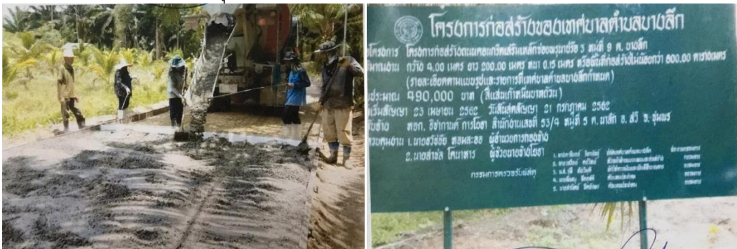
๗. โครงการก่อสร้างถนน คสล.ซอยพรุณาปรีธ ๓ ม.๙
