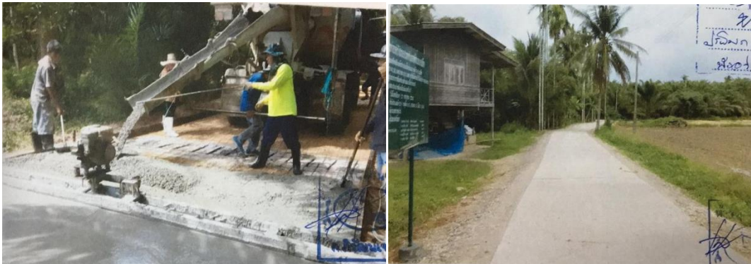
๖. โครงการก่อสร้างถนนคสล. สายซอยโชคอำนวย ม.๔
