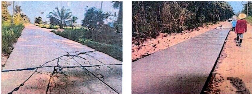
11.โครงการซ่อมแซมถนนคสล.สายหนองเนียน-เขาหราชด ม.11
