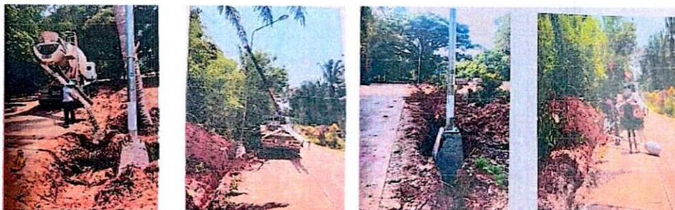
13.โครงการติดตั้งไฟฟ้าแสงสว่างสาธารณะ ซอยวัดถ้ำเขาม้ายัง ม.5 ตามแบบบัญญัติวิถีกรรมไทยโดยสำนักงานประมาณ รหัส 07010015
