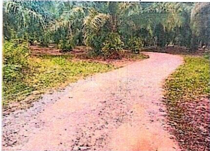
9.โครงการก่อสร้างถนนหินลูกรังซอยร่วมใจรักษ์ ม.9
