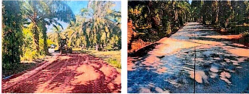
10.โครงการก่อสร้างถนนคสล.ดอนรักษ์ ซอย 3 ม.10 (ส่วนที่เหลือ)
