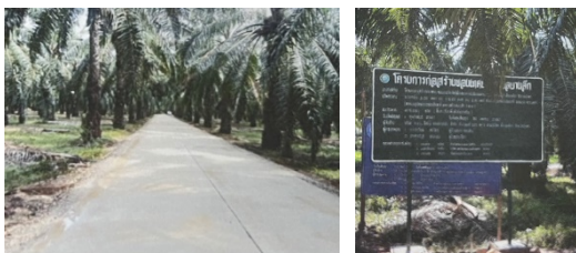
๒๙.โครงการก่อสร้างถนนคสล.ซอยประชาสามัคคีเชื่อมถนนฝายนา (ฝั่งถนนฝายนา) ม.๕
