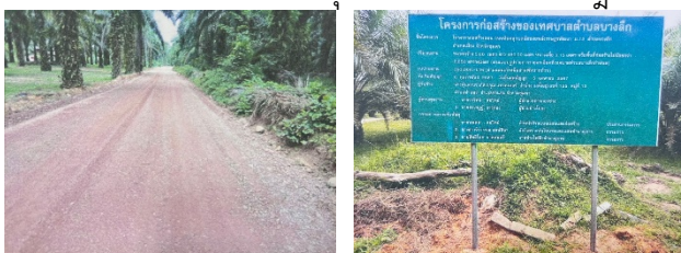
๑๗.โครงการก่อสร้างถนนหินคลุกบดอัดซอยพลังราษฎร์พัฒนา ม.๑๒
