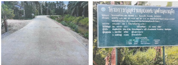
๒๗.โครงการก่อสร้างถนนคสล.ซอยรักขันโท ม.๒
