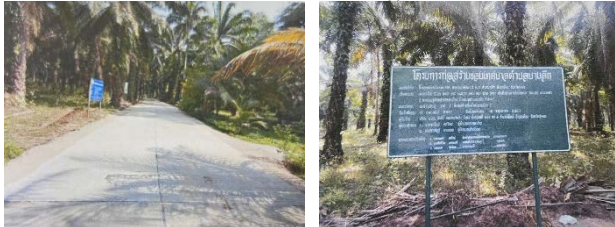
๑๔.โครงการก่อสร้างถนนคสล.สายราษฎร์พัฒนา ๒ ม.๑๑
