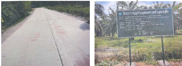
๑๖.โครงการก่อสร้างถนนคสล.ซอยศาลาเชิงอนุรักษ์(ถ้องแพแลกวาง) ม.๑๒
