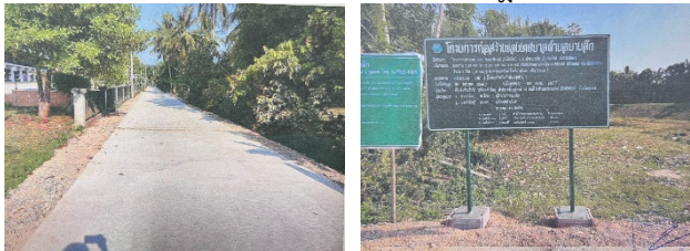
๑๕.โครงการก่อสร้างถนนคสล.ซอยอารีย์ราษฎร์(ข้างโชคดีเค) ม.๔
