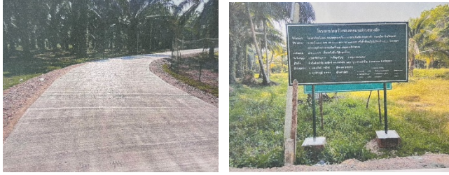
๑๘.โครงการก่อสร้างถนนคสล.ซอยพรุณาปรีอ ๓ ม.๙ (ส่วนที่เหลือ)
