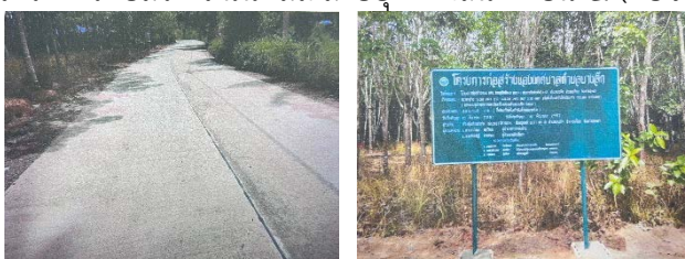
๒๓.โครงการก่อสร้างถนนคสล.สายอุทิศพัฒนา ตอน ๔ (ต่อจากเดิมที่เหลือ) ม.๑๒
