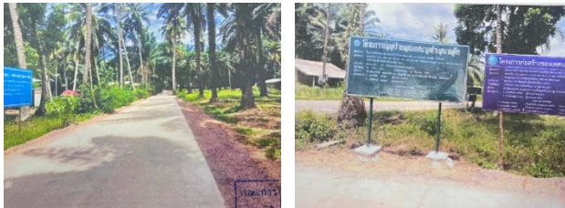
๒๖.โครงการก่อสร้างถนนคสล.สายประชาร่วมใจ พร้อมบล็อกระบายน้ำ ม.๑๑
