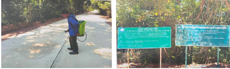
๑๒.โครงการก่อสร้างถนนคสล.สายหนองเนียน-เขาหิราด ม.๑๑
