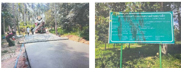
๒๒.โครงการก่อสร้างถนนคสล.สายท่ากระดาน ซอย ๘ (มินิมาร์ท) ม.๑ (ส่วนที่เหลือ)
